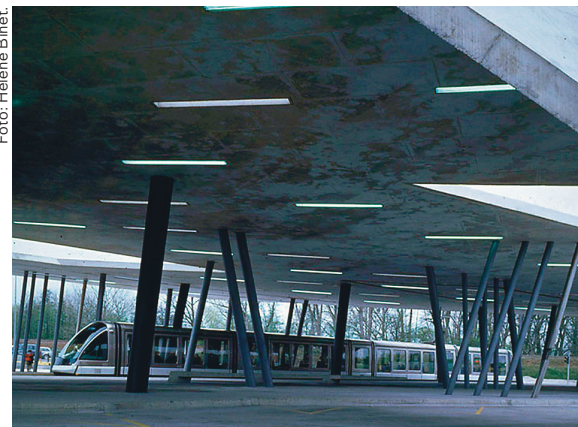
Autoparkla ja terminalihoone, Hoenheim Nord, Strassburg, Prantsusmaa. Arhitekt: Zaha Hadid. Võidetud auhind: Euroopa Liidukaasaegse arhitektuuri auhind – Mies van der Rohe auhind 2003. aastal.
